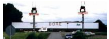
Vår lauvadandläggning vid motorvägen, E6:an i Varberg
